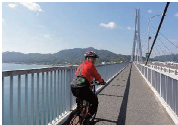
図6 世界一の斜張橋=多々羅大橋
